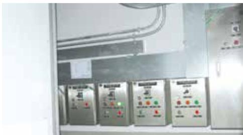
为环控室开关柜而配备的现场手操箱。对现场设备进行开启、停止或其它操作，实现远程就地控制，箱体材质（SUS不锈钢、SPCC冷轧板、ABS和PC等多种材料）和元件配备方案多元化以满足用户不同需求。
