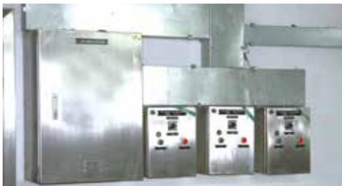
产品广泛适用于各地铁站、隧道。为配套设备用电，检修工具用电、检修线路而配备的动力箱。箱体材质有（SUS不锈钢、SPCC冷轧板、ABS和PC等多种材料）和元件配备方案多元化以满足用户不同需求。
